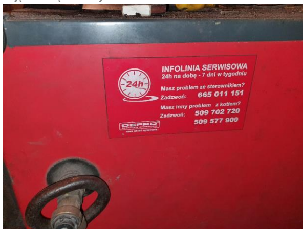
Zdjęcie. Wnętrze budynku.
