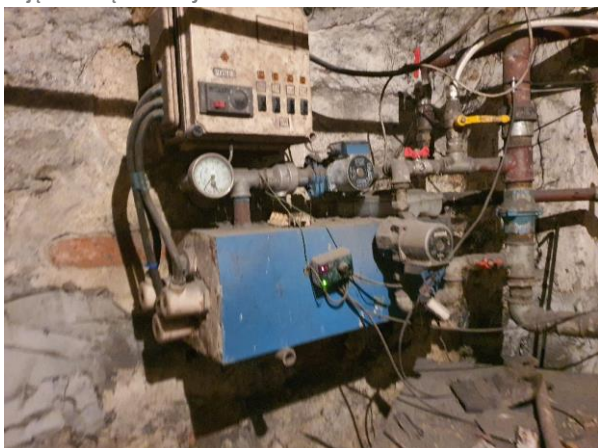
Zdjęcie. Wnętrze budynku.
